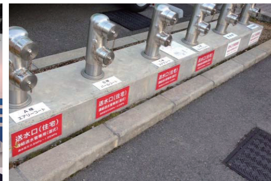
プレートに出力フィルム貼り
