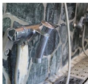
堆積した温泉スケール除去
