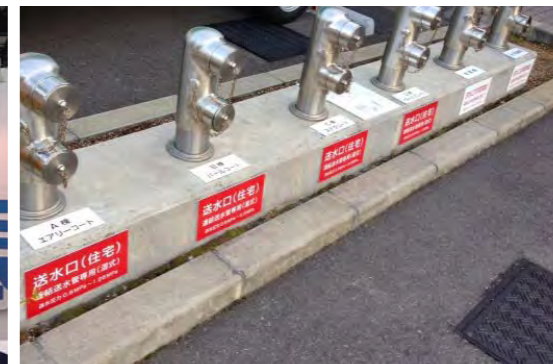
プレートに出力フィルム貼り
