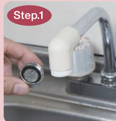
使用中の蛇口先端部を外す
